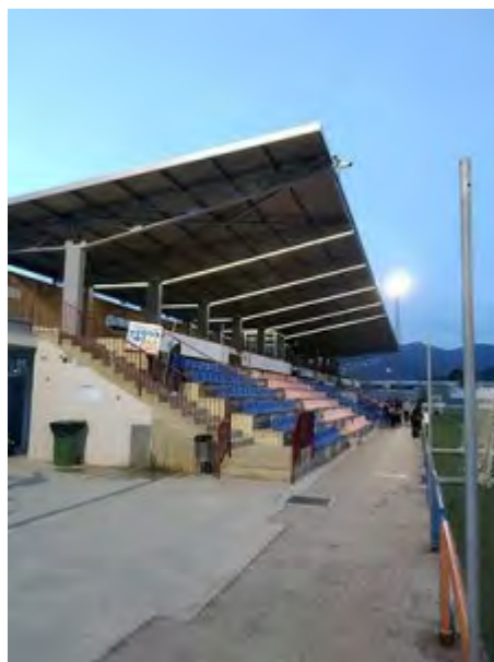
Aspecte que presenta la nova coberta de l'estadi municipal del Mas Oliva
