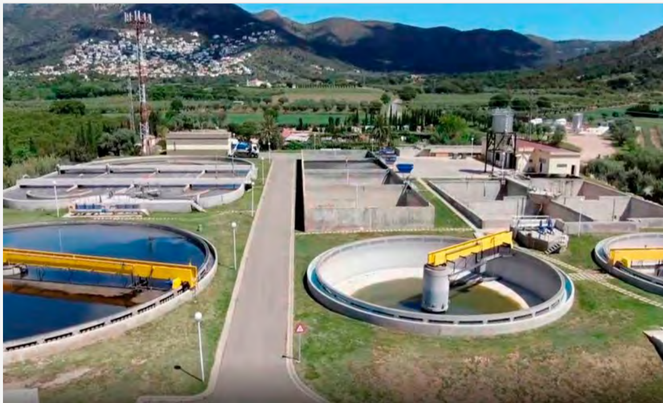
Estació depuradora de Roses
