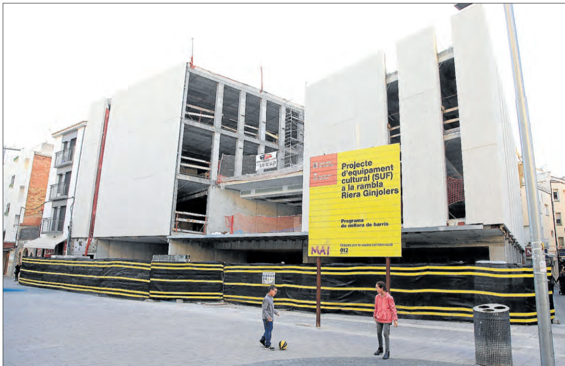
El nou edifici de la SUF, que ja té forma, al centre de Roses. GERARD BLANCHÉ
