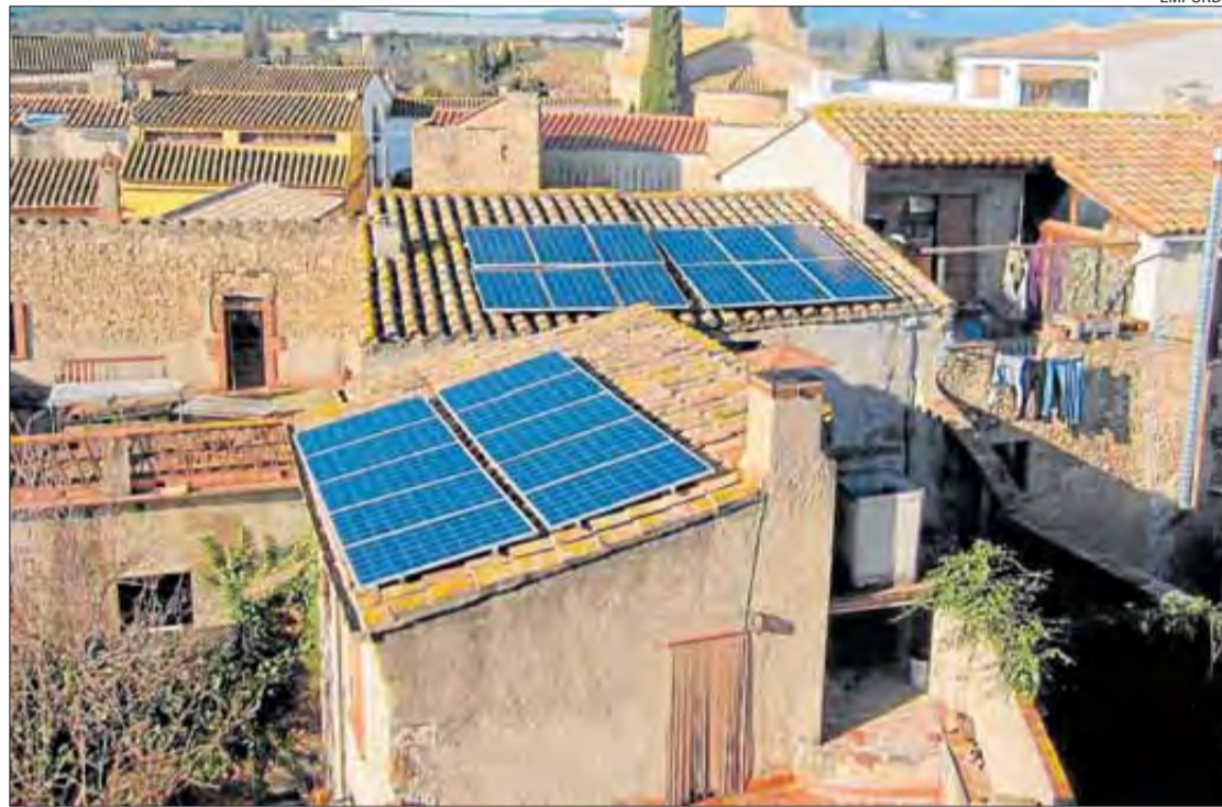
Aquesta instal·lació de plaques solars estalvia aproximadament un 30% de la factura de la llum.
