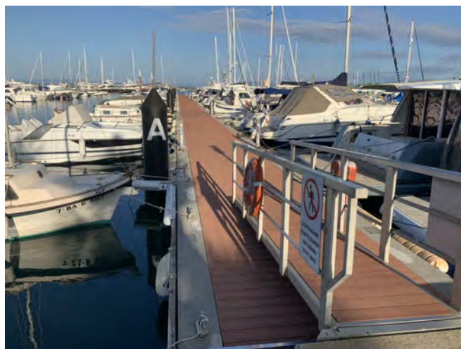
Un dels pantalans renovats del Port rosinc. AJUNTAMENT
