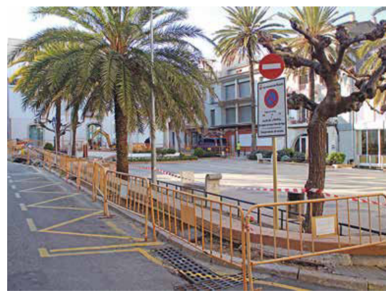
LA PLAÇA. Amb les obres es crearà un rampa d'accés a la biblioteca BASILI GIRONÈS
