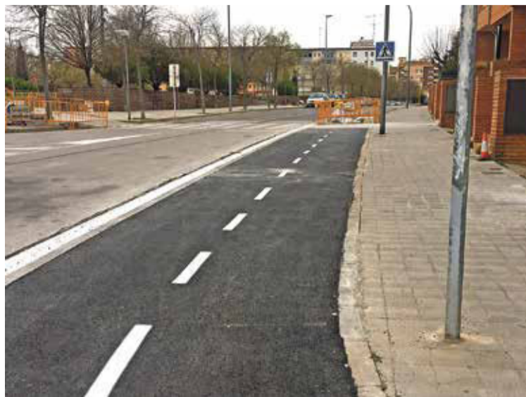
AQUEST DILLUNS. Un tram de les obres al carrer Fages de Climent
