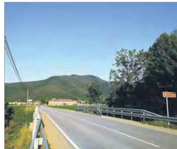
Una imatge del pont de Verntallat sobre el riu Fluvià, on ara es duran a terme els treballs de millora i seguretat ■ J.C.
