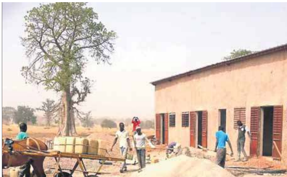
Una imatge de les obres a l'escola que s'està construint al Senegal a partir d'una iniciativa impulsada des de l'Empordà ■ AETTO
