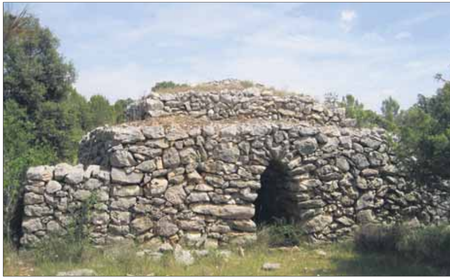
Una barraca de pedra seca, fotografiada al terme municipal de Llers (Alt Empordà) ■ ESTEVE CARRERA
