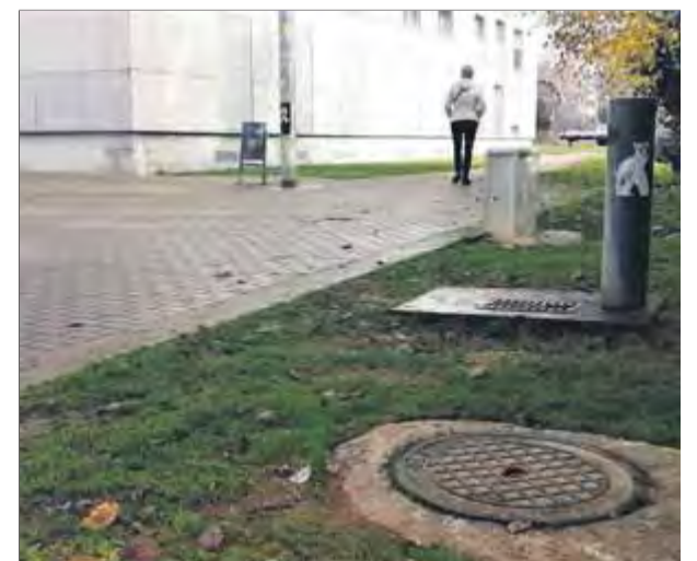
Tapa de claveguera del passatge que hi ha entre Cal General i el rec de Can Teixidor ■ R.E.
