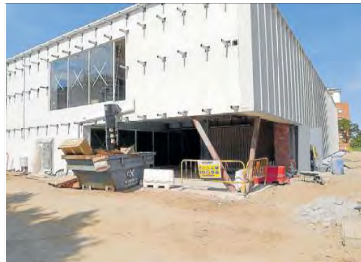
La vista actual del futur edifici del CAP a Figueres. JAUME PURCALLAS
