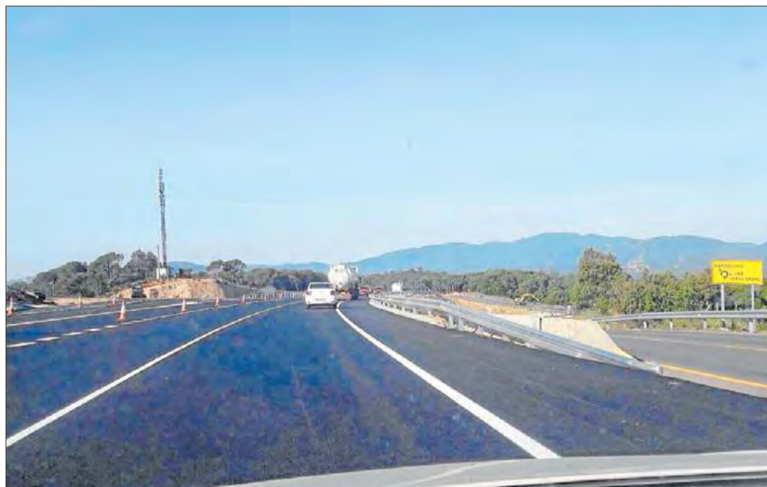
Imatge del nou tram de l'N-II entre Maçanet i Tordera al desviament cap al nucli de Terra Brava. MARTÍ SANTIAGO
