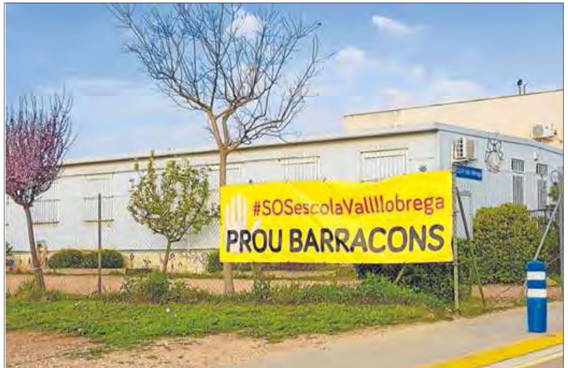
Imatge d'arxiu dels mòduls prefabricats que conformen l'escola de Vall-llobrega, al Baix Empordà. DIARI DE GIRONA
