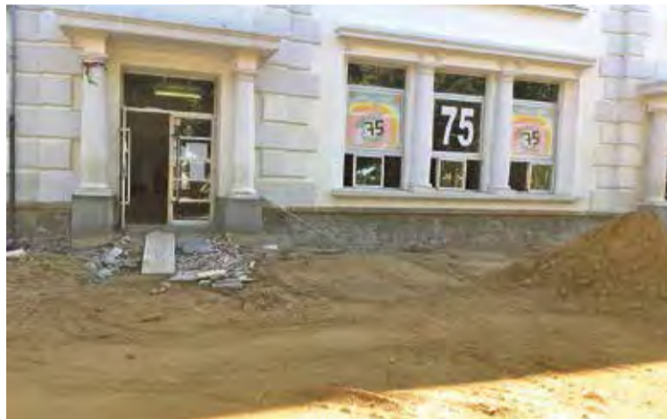
OBRES. Treballs al pati del Narcís Monturiol
