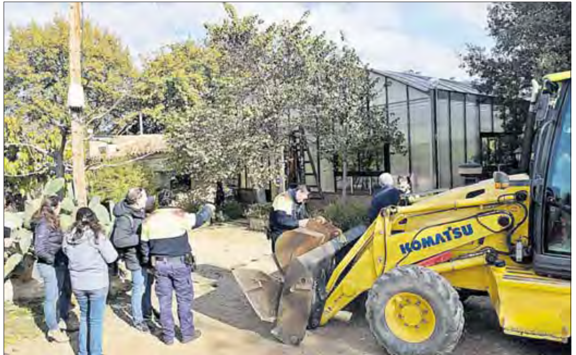
Els Mossos, amb les màquines i les edificacions que es volien tirar a terra, ahir. CONXI MOLONS
