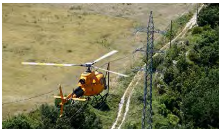
LES REVISIONS. Les línies s'inspeccionen amb helicòpter
