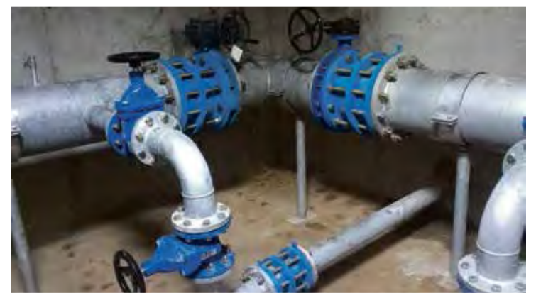
CANONADA. Exemple de canalització d'abastament d'aigua en alta
