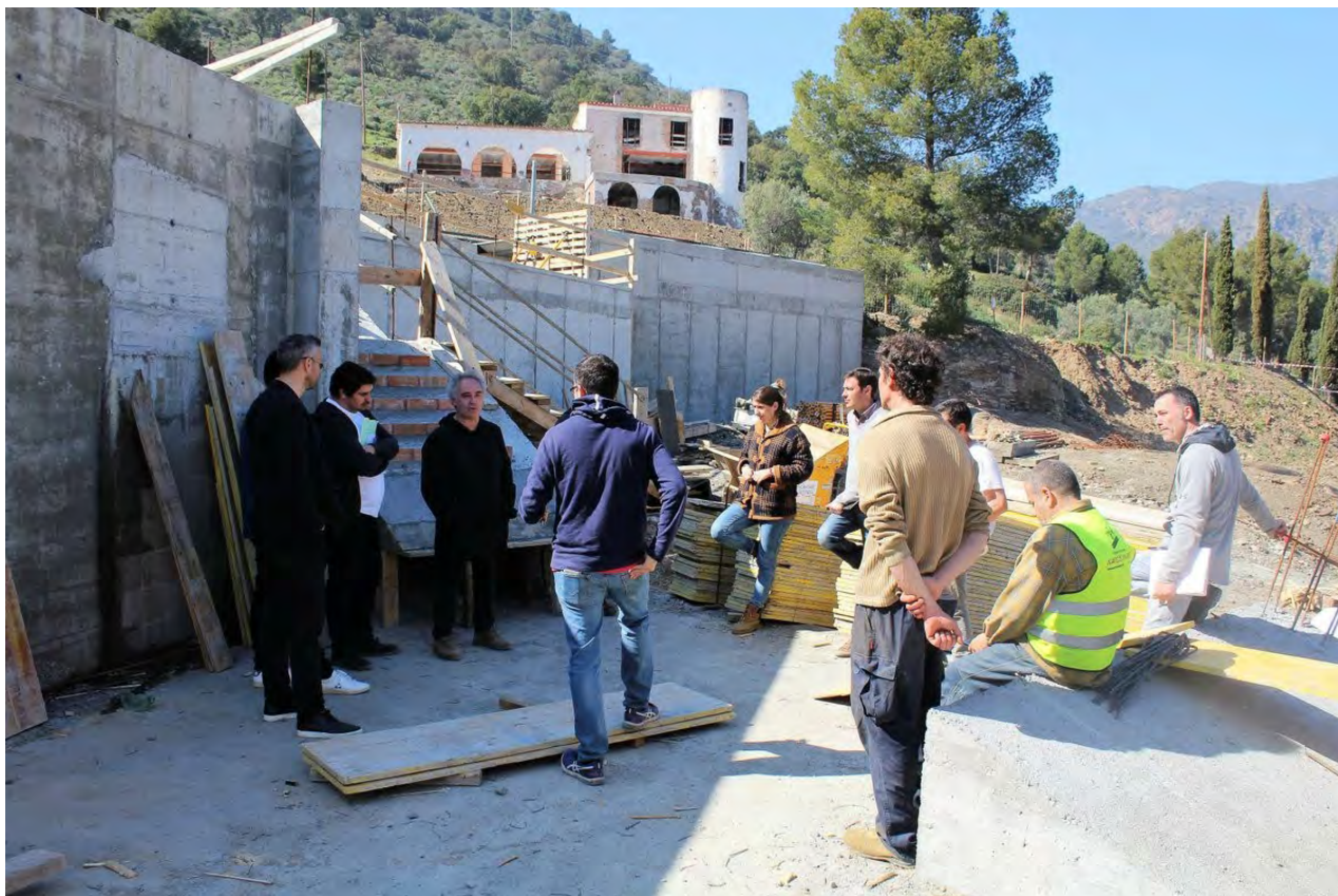
Ferran Adrià amb l'equip d'obres del seu restaurant | Foto: Twitter Ferran Adrià
