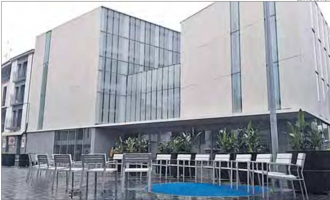
Una de les intervencions seran a la canalització de la façana.
