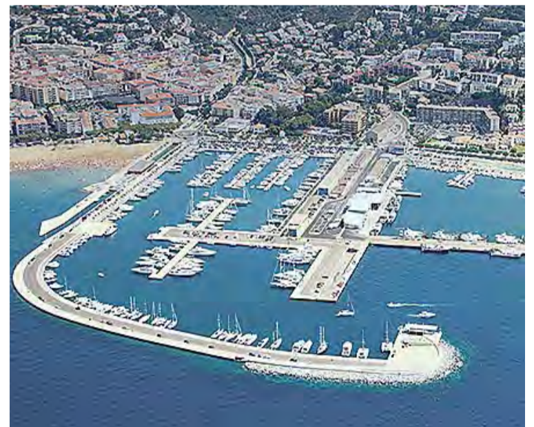
PORT DE ROSES. En aquesta instal·lació es col·locaran 119 punts de llum LED PORTS
