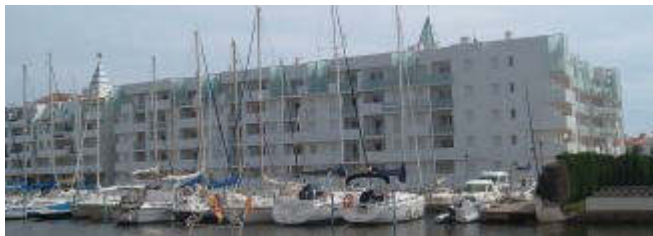
Edifici del Royal Marine. AJUNTAMENT DE ROSES
