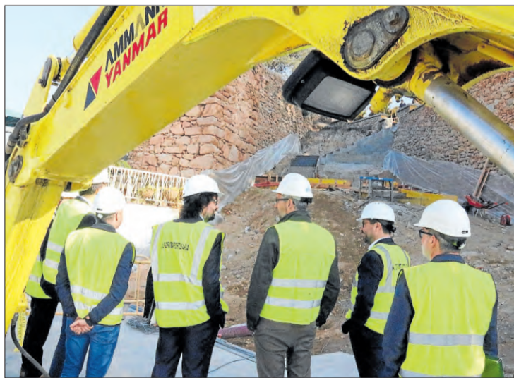
Font va visitar les obres al moll del Fortí de Sant Feliu. JORDI ALTESA/ACN
