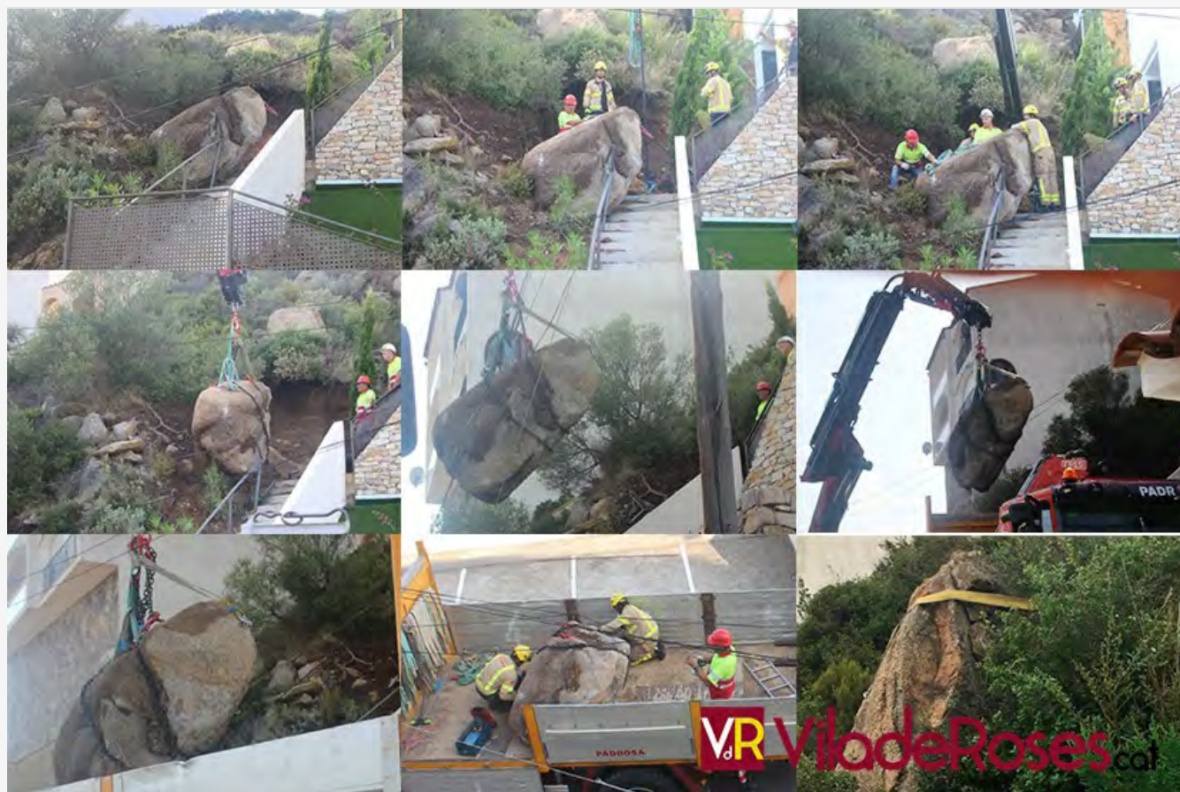
Seqüència de la retirada de la roca, i l'assegurament provisional de la pedra que hi ha a dalt (última imatge)
