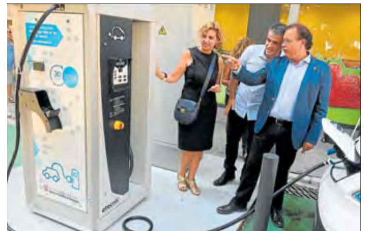
Punt de càrrega elèctric instal·lat a Figueres. AJ. FIGUERES
