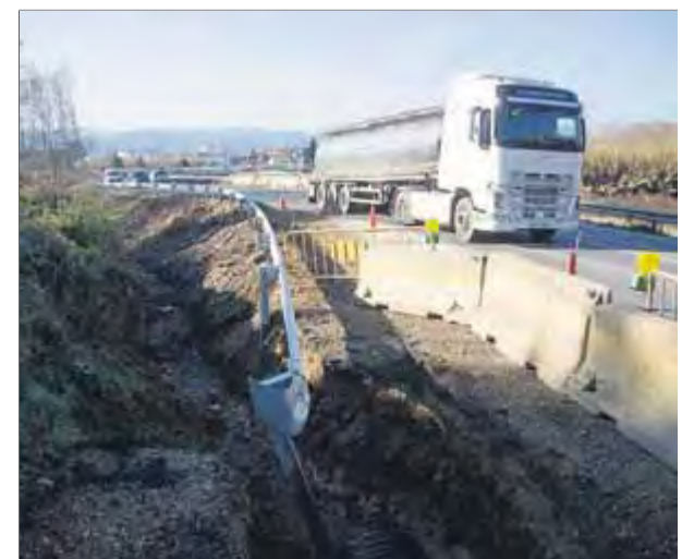
A partir d'avui tornaran a estar operatius els dos carrils de la carretera. Imatge de les obres al desembocament ■ QUIM PUIG
