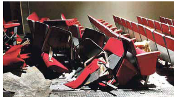
DESMUNTANT L'INTERIOR. L'enderroc de l'edifici és imminent
