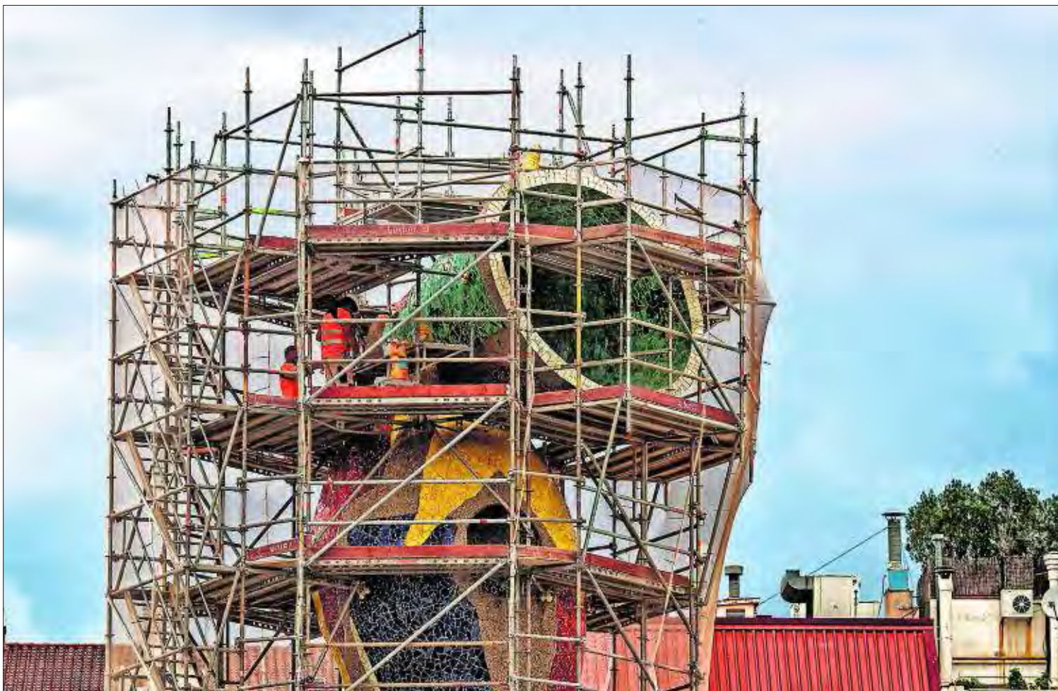
Obras de restauración en la escultura Dona i ocell , de Joan Miró. / JOAN SÁNCHEZ
