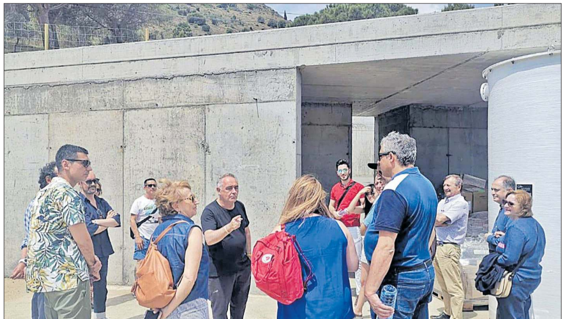
Ferran Adrià va visitar ahir les obres d'elBulli 1864. @FERRANADRIA
