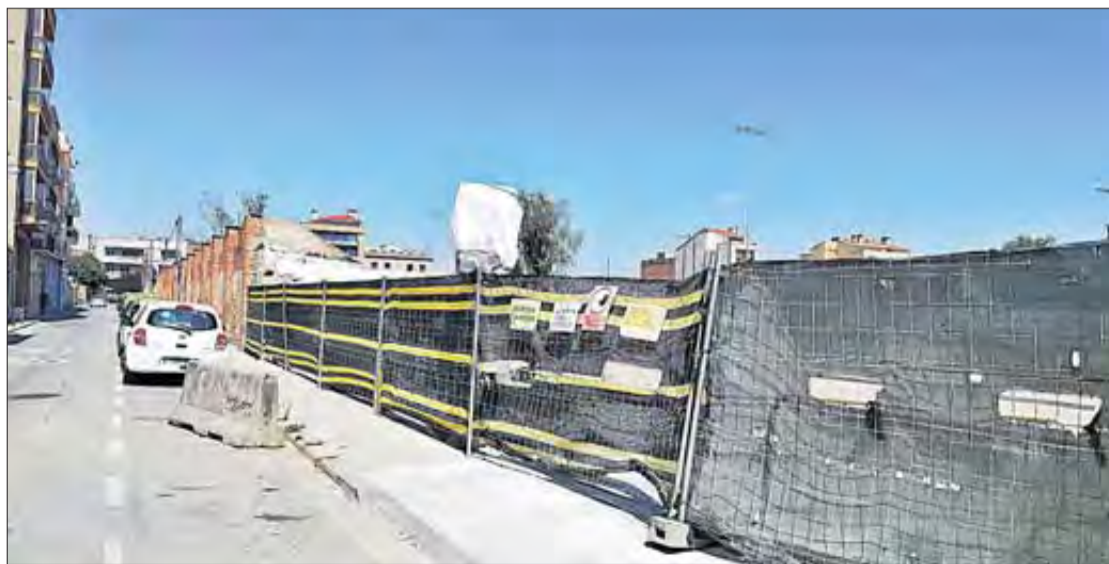
L'aparcament del camp del Far, encara en obres. ANNA FONT
