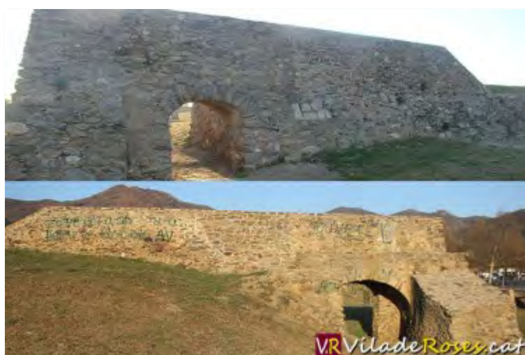
Els treballs han permès millora la fesomia exterior de la Ciutadella per la banda de la muralla de la Porta de Terra
