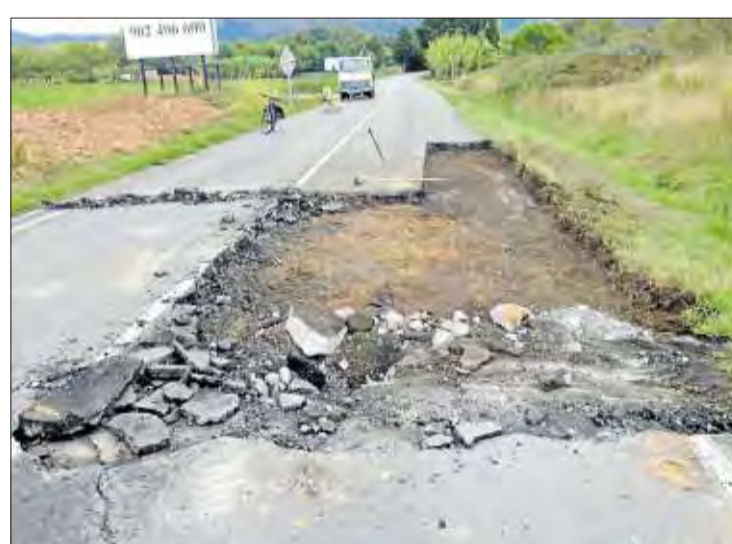
Treballs d'asfaltat a la ronda de Roses. AJUNTAMENT DE ROSES
