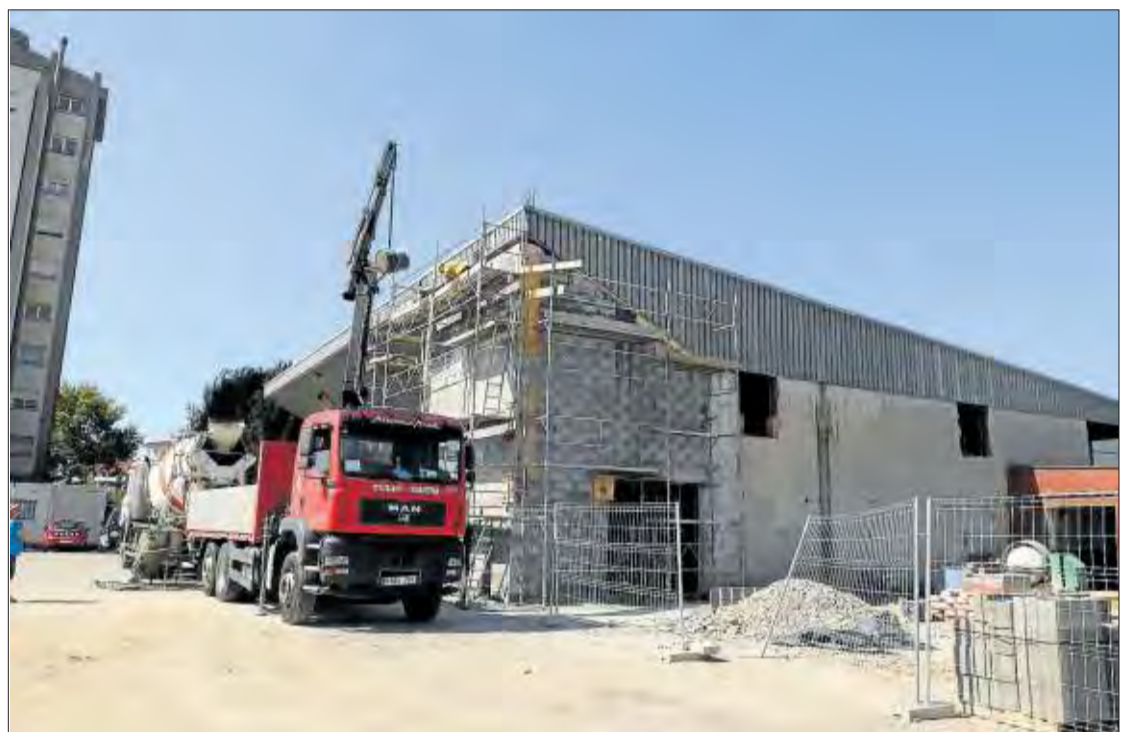
L'estat en que es troben actualment les obres del parc de Bombers. CONXI MOLONS
