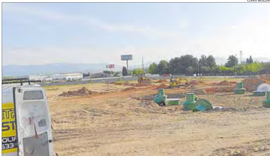
Les obres de les gasolineres, a 300 metres de l'actual de la firma Petromiralles.
