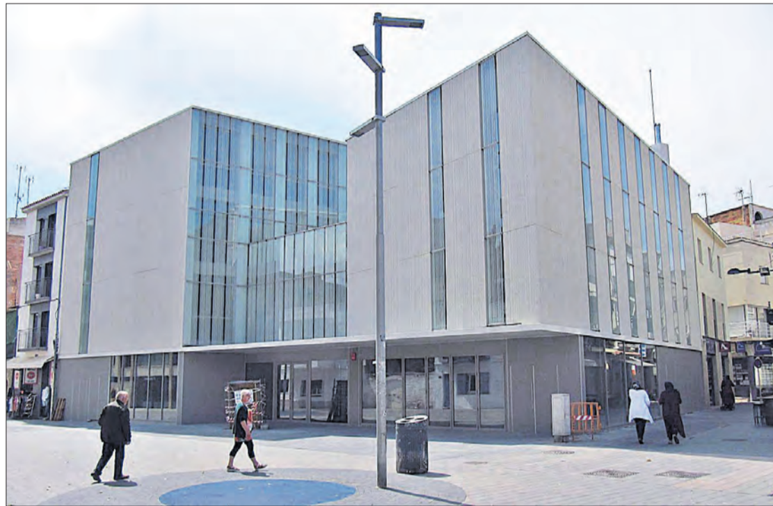
L'edifici de la SUF de Roses, amb l'exterior ja acabat. GERARD BLANCHÉ
