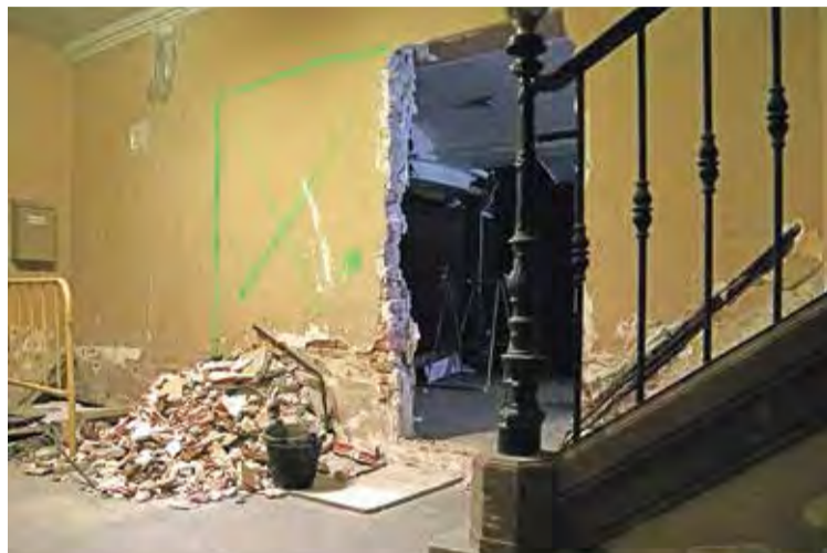
OBRES. Part inferior on ja han començat els treballs
