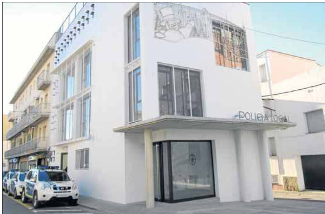
L'edifici de la Policia Local presenta un aspecte molt més modern després de la reforma. GERARD BLANCHÉ
