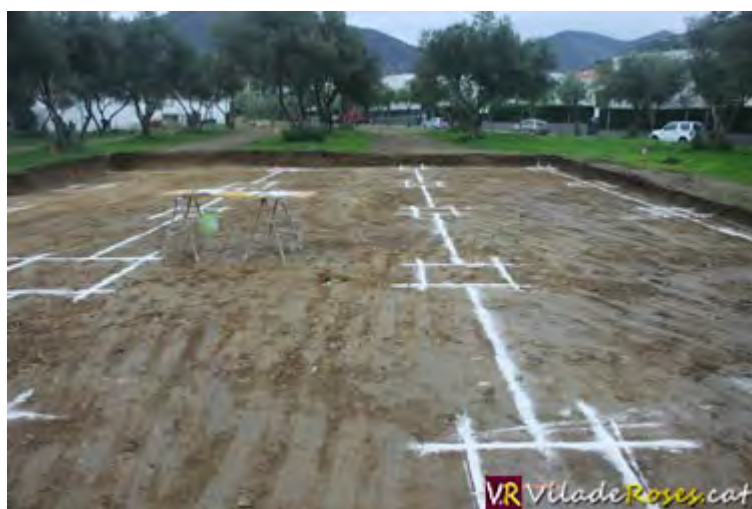
Marcatge de la cimentació de l'edifici del futur tanatori de Roses
