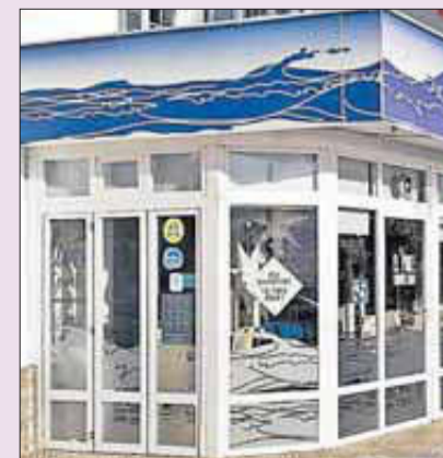
Les marquesines de front de mar.
