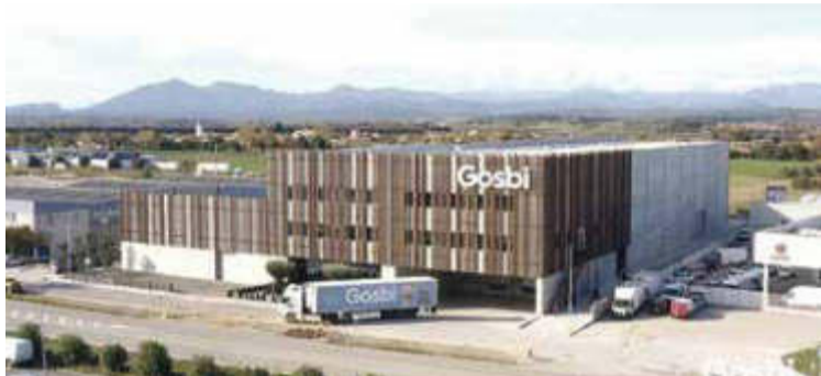
NOVA SEU. La instal·lació consta de 9.000m 2
