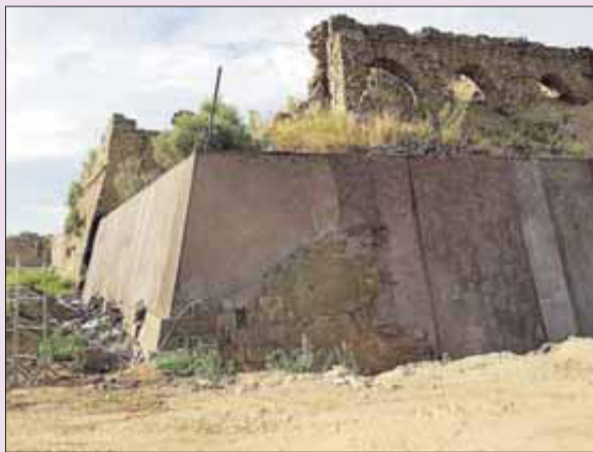
Estat de les obres, la setmana passada.
