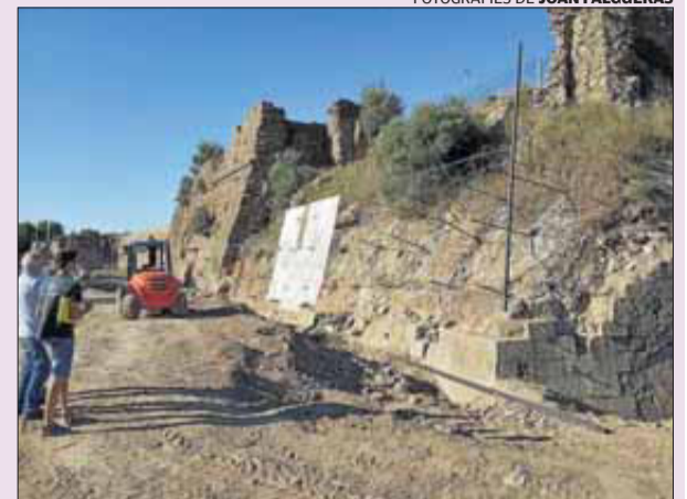
Contenció de la part baixa per assegurar-ne l'estabilitat.
