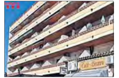
Edifici afectat, a Roses.
