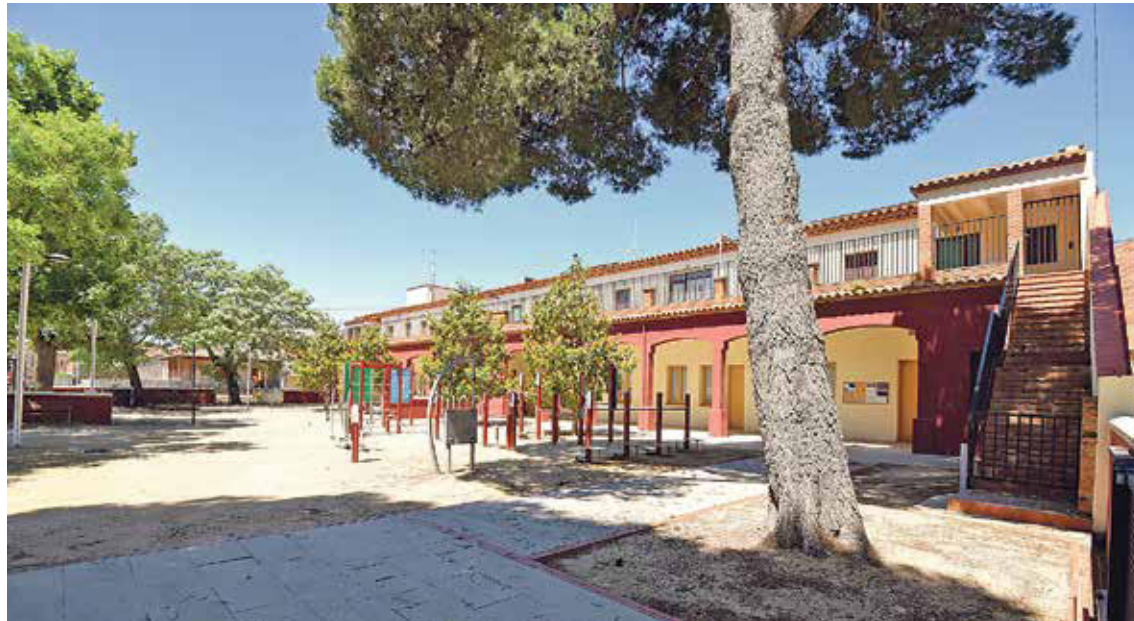
PERALADA. El nou institut, que començarà amb dues línies de 1r d'ESO, s'ubicarà a l'edifici de les antigues escoles ÀNGEL REYNAL
