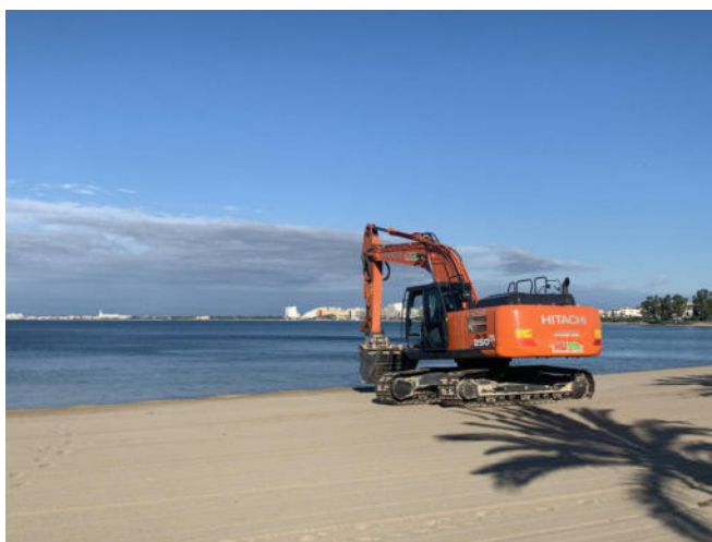
Els treballs per recuperar l'amplada de sorra. EMPORDA.INFO
