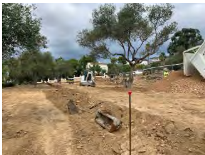
Inici d'obres del correccan
