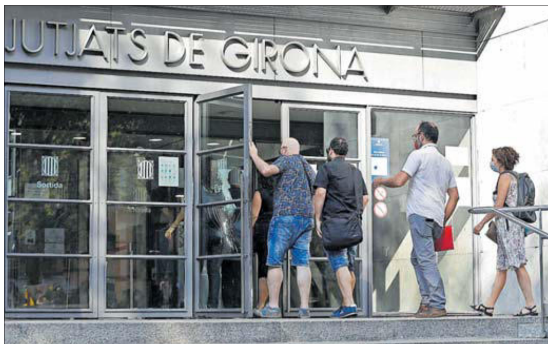
Façana dels Jutjats de Girona situats a l'avinguda Ramon Folch, en una fotografia d'arxiu. ANIOL RESCLOSA/ARXIU
