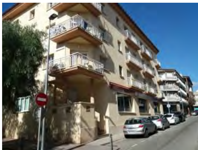
Actuació al carrer Arquitecte Gaudí
