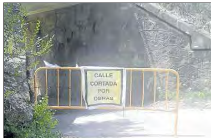
La tanca que barrava el pas per les obres. J.REMOLINS
