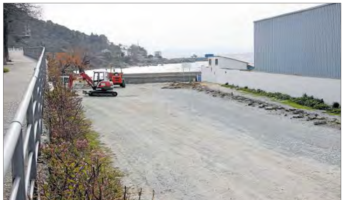
Les màquines, treballant a l'espai a tocar la platja dels Palangrers. AJUNTAMENT DE ROSES
