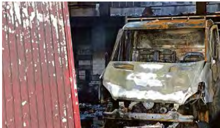
FURGONETA CALCINADA. Detall d'un dels desperfectes a l'interior de la nau
