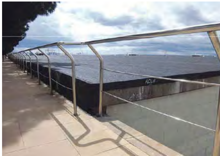
MIRADOR. Aviat s'urbanitzaran les cobertes dels edificis del moll pesquer
