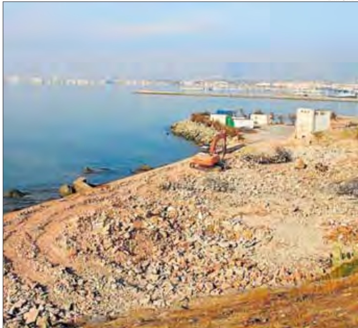
Les obres d'enderroc de l'antiga depuradora.
