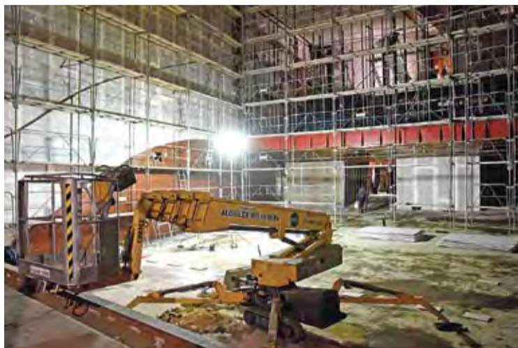
REHABILITACIÓ. Ja s'ha instal·lat la bastida per començar les obres
