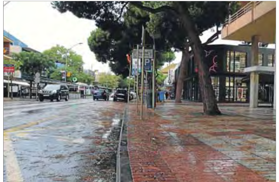
A l'avinguda s'Agaró, principal eix comercial de Platja d'Aro, també s'embassa aigua quan plou, però les obres dels nous col·lectors s'ajornen fins al 2021, per minimitzar-ne l'impacte ■ E.A.
