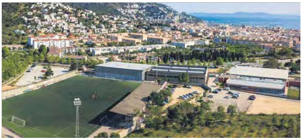
La zona esportiva de Roses, on es construirà el nou edifici per instal·lar-hi la central i la xarxa de biomassa ■ AJ. DE ROSES
