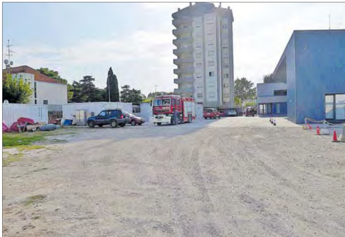
L'accés al Parc de Bombers de Figueres, pendent d'asfaltar (arxiu). CONXI MOLONS
