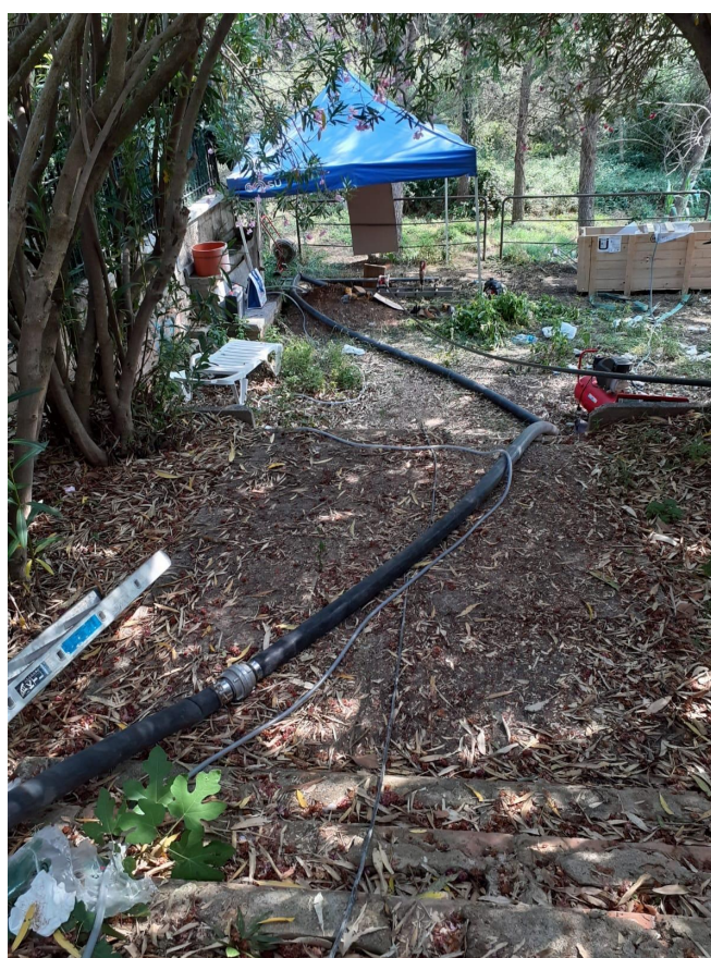
Els treballs han estat executats amb un sistema de mànega, sense necessitat d'obra civil AJUNTAMENT DE ROSES
