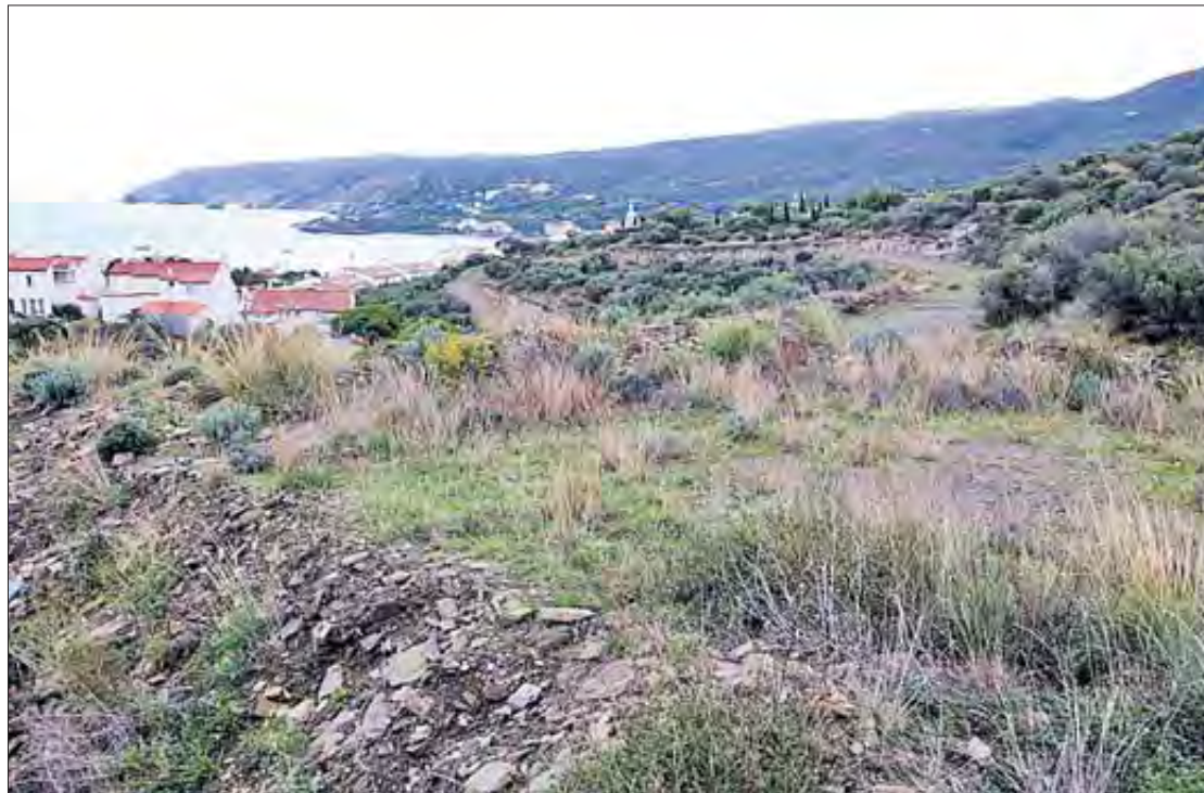
La zona de Sa Guarda on s'ha obert un dels vials d'accés a la urbanització. ACN
