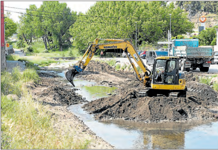
Les màquines, treballant per retirar els sediments. JOSEP RIBAS FALGUÉS
