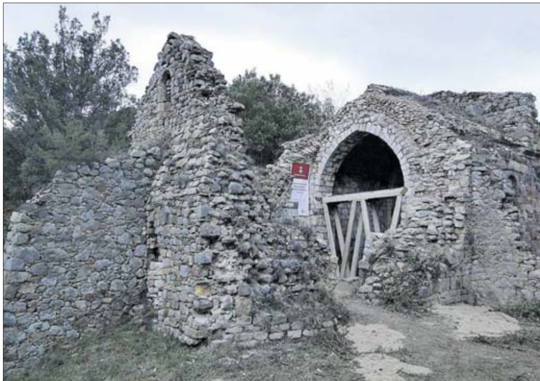
L'església d'Albanyà on s'està actuant per tal de consolidar-la. CENTRE EXCURSIONISTA EMPORDANÈS
