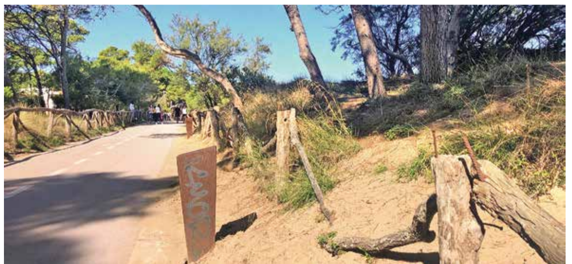
SANT MARTÍ D'EMPÚRIES. Les tanques i les passeres de l'emblemàtic itinerari s'han de renovar
